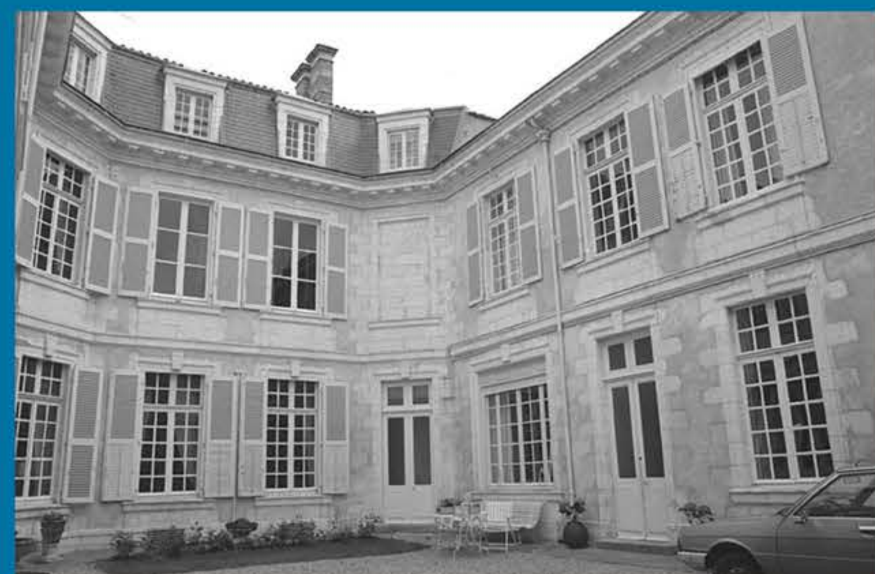
Façade sur cour
