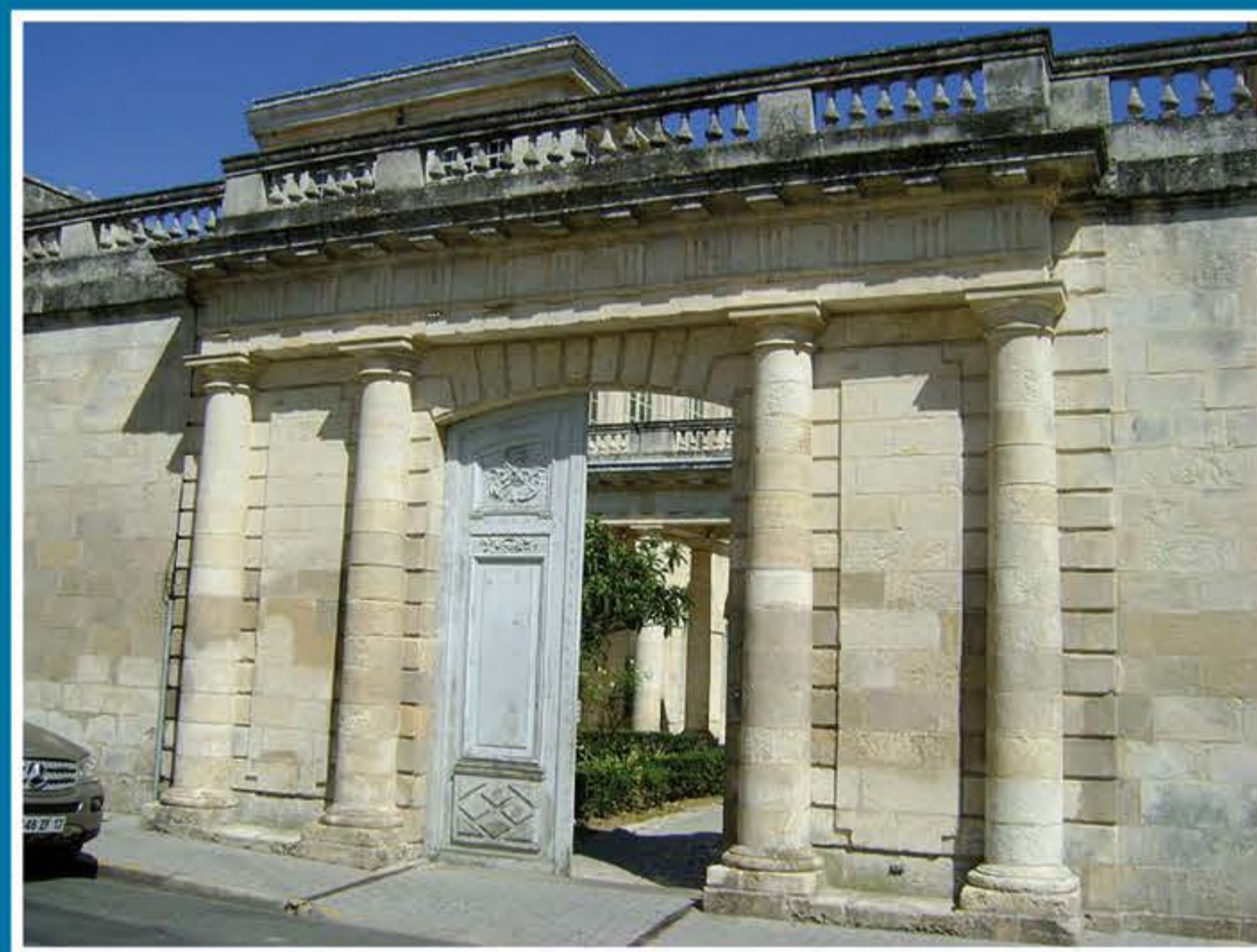
Portail d'accès par la rue Admyrault
