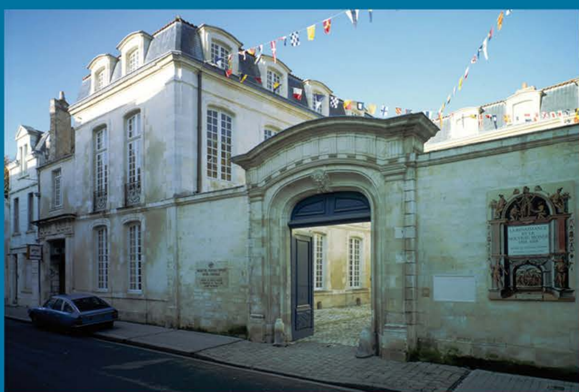
Façade sur cour - Rue Fleuriau
