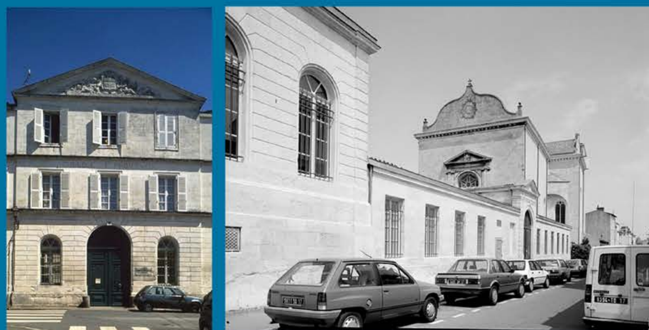
Entrée principale Rue Jaillot & élévation sur la rue du Collège avec chapelle (c) Région Poitou-Charentes, Inventaire du patrimoine culturel
