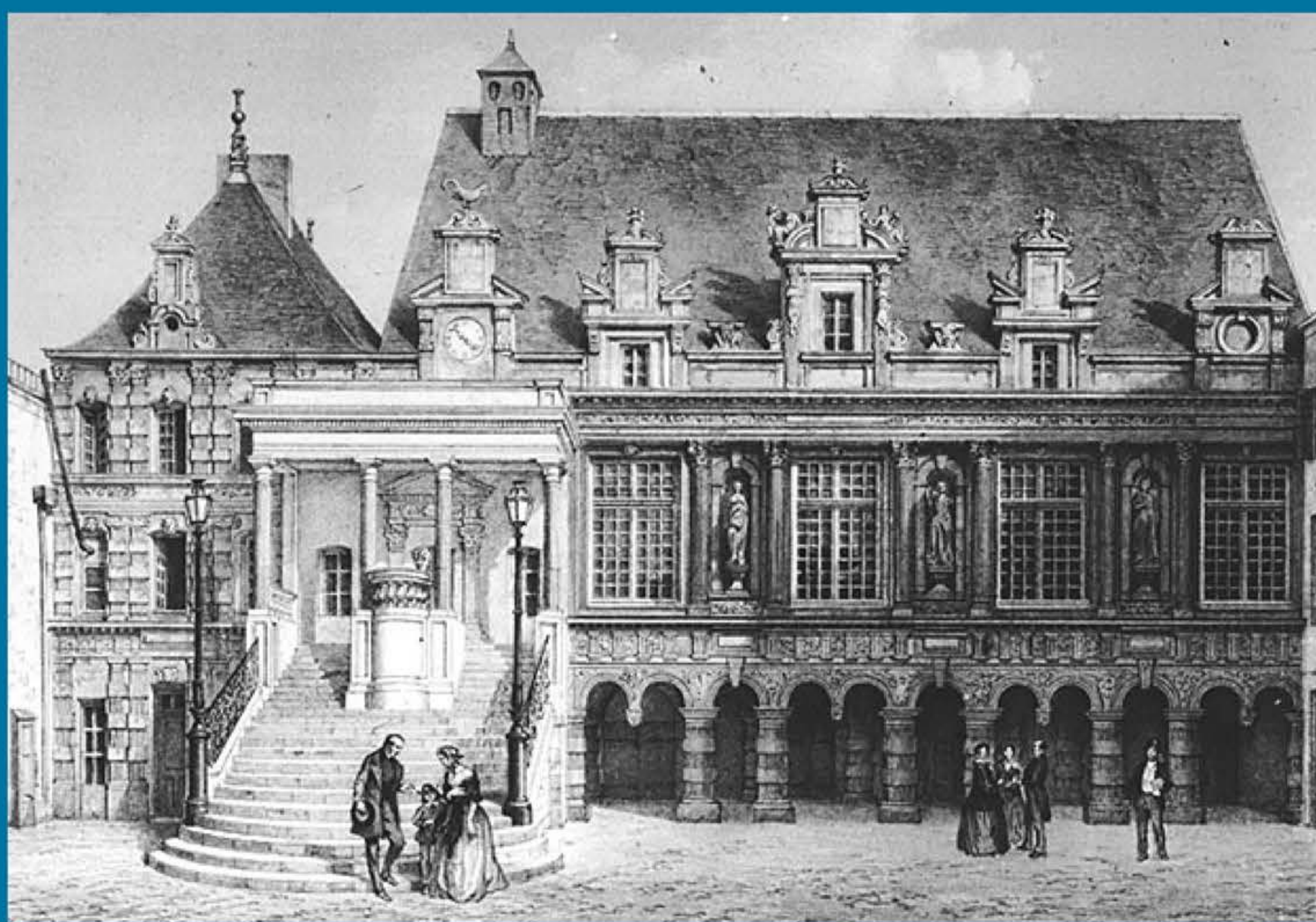
Façade intérieure de l'Hôtel de ville au XIX e siècle. À gauche, le pavillon Renaissance édifié vers 1550 qui serait attribué, sans preuve certaine, à Léonard de la Réau, architecte de Fontenay-le-comte. À droite, le corps de logis construit entre 1595 et 1607, soutenu par une rangée de colonnes toscanes.
